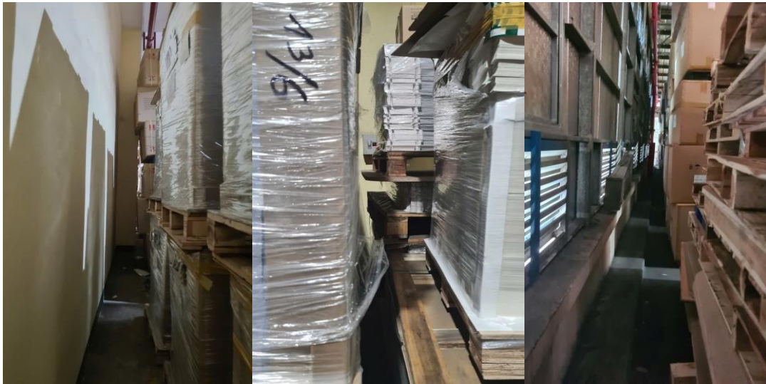
Hình 1: Pallet chất hàng kín lối đi, để pallet che khuất tủ điện.
