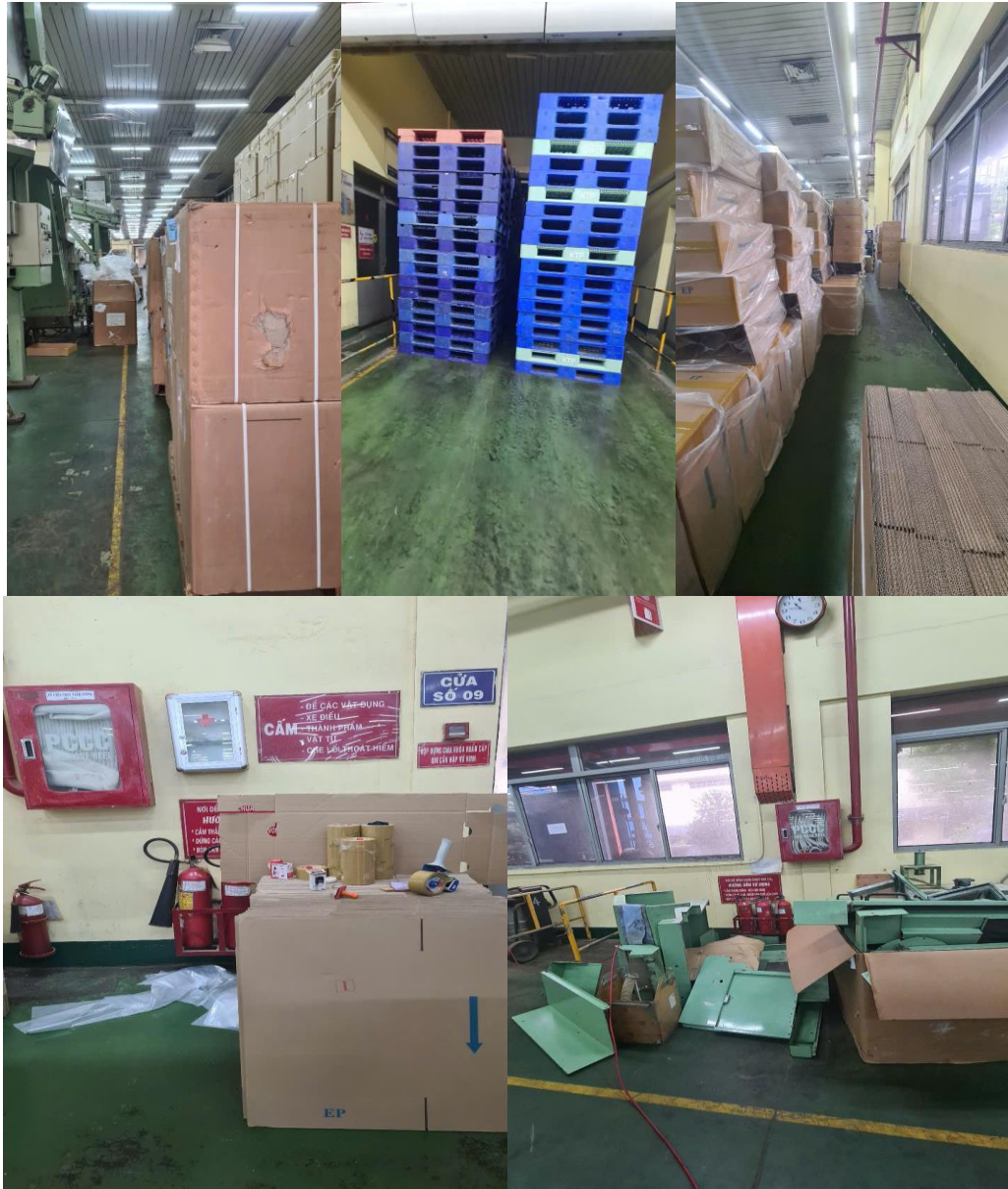
Hình 7: Để vật tư chặn lối thoát hiểm, thiết bị PCCC tại PXVB.
